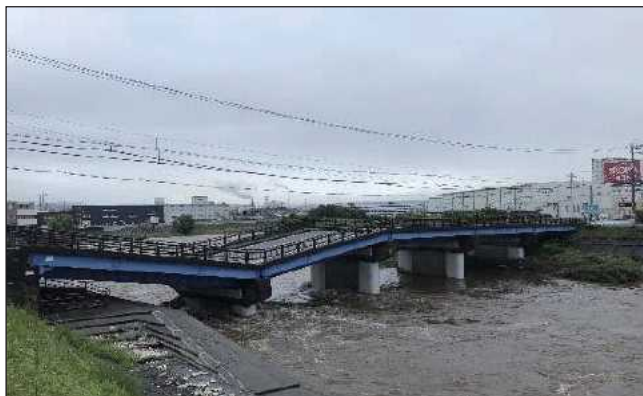
令和3年7月 沼津市黄瀬川大橋
